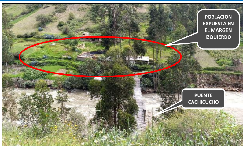
FOTOGRAFÍA N° 01: TRAMO CRÍTICO 01 EN EL RÍO SANTA SECTOR HUANTUMEY, SE OBSERVA PUENTE EXPUESTO Y EROSION EN LA RIVERA AGUAS ARRIBA Y ABAJO DEL PUENTE CACHICUCHO.
